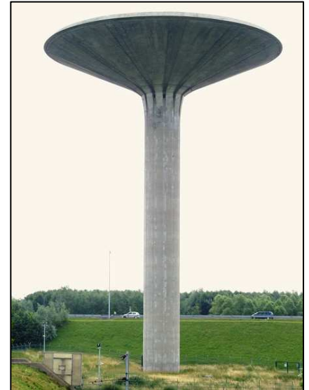
Figure 1 : château d'eau à l'aéroport Charles-de-Gaulle
